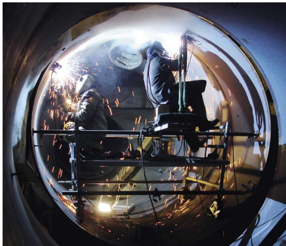
Większa średnica nowego rurociągu pozostawiała z lewej i prawej strony rury zbyt mało miejsca do pracy. Z tego względu spawanie musiało być wykonywane od wewnątrz. Dym towarzyszący spawaniu był odsysany przez węże.
