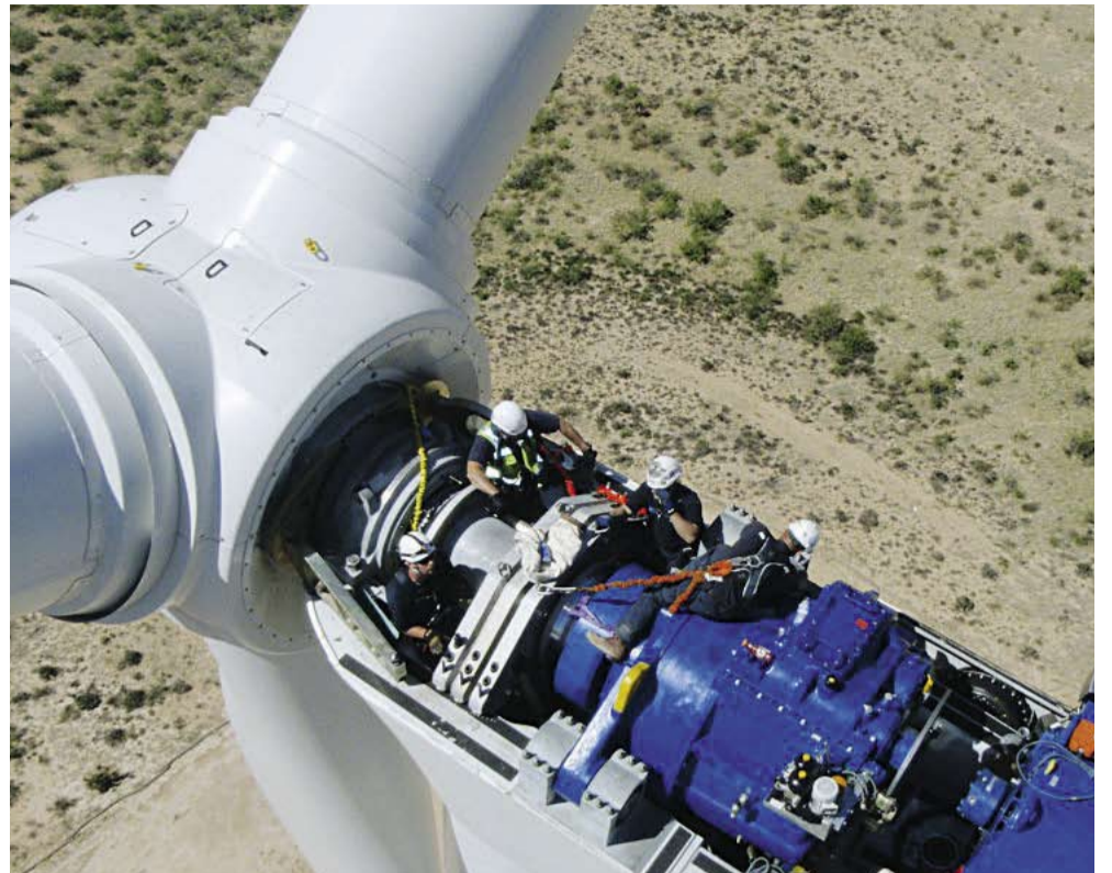
Specjaliści z BIS Salamis Inc. docierają do wnętrza turbiny po drabinie. Duży upał utrudnia pracę przede wszystkim w miesiącach letnich.
