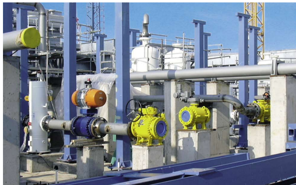
Rurociągi nowego zbiornika gazu są obliczone na wysokie ciśnienia robocze od 120 do 160 bar. Dlatego też spawy poddano odpowiednio szczegółowym badaniom.
