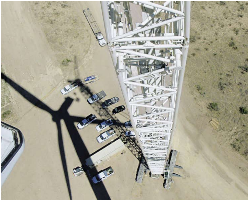
Niektóre instalacje wiatrowe mają wysokość ponad 90 metrów. Do wymiany ważących 20 ton przekładni BIS Salamis Inc. stosuje najwyższe dźwigi na świecie.
