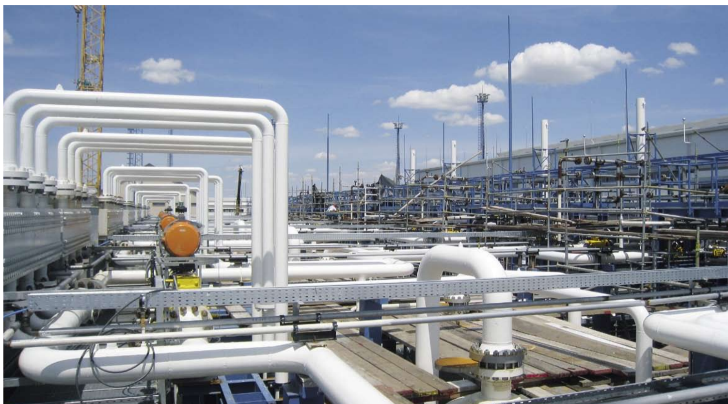
Nad- i podziemne przewody wysokociśnieniowe potrzebne dla zbiornika gazu ziemnego „Szőreg-1” ważyły łącznie 260 ton. Około 60 procent prefabrykacji wykonała BIS Hungary w warsztacie w Tiszaújváros.
