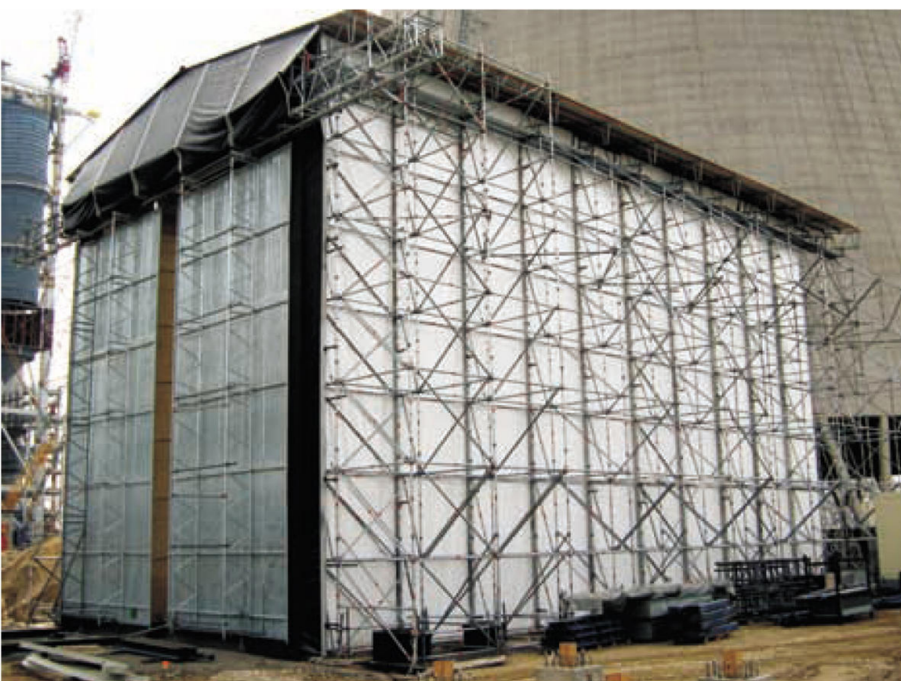
Realizacja: tymczasowa hala przemysłowa w Elektrowni Bełchatów
