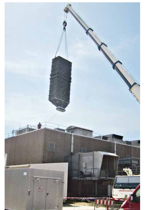
Wyciąganie ważącego około 35 ton reaktora przebiegało równie bezproblemowo jak zabudowa nowego jedenastometrowego kominu spalin.
