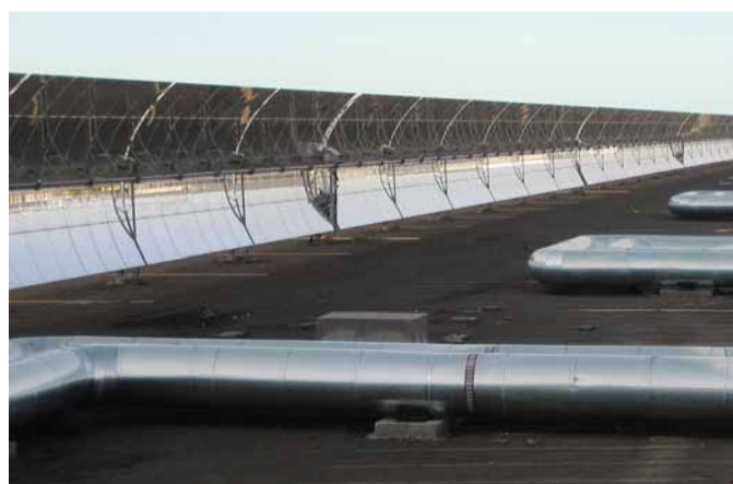
Hiszpańska i polska spółka BIS przy budowie elektrowni Andasol 1 odpowiadały za izolację największych rur.
