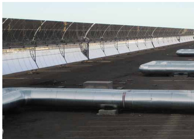
Die spanische und die polnische BIS Gesellschaft waren beim Bau von Andasol 1 für die Isolierung der größeren Rohre verantwortlich.
