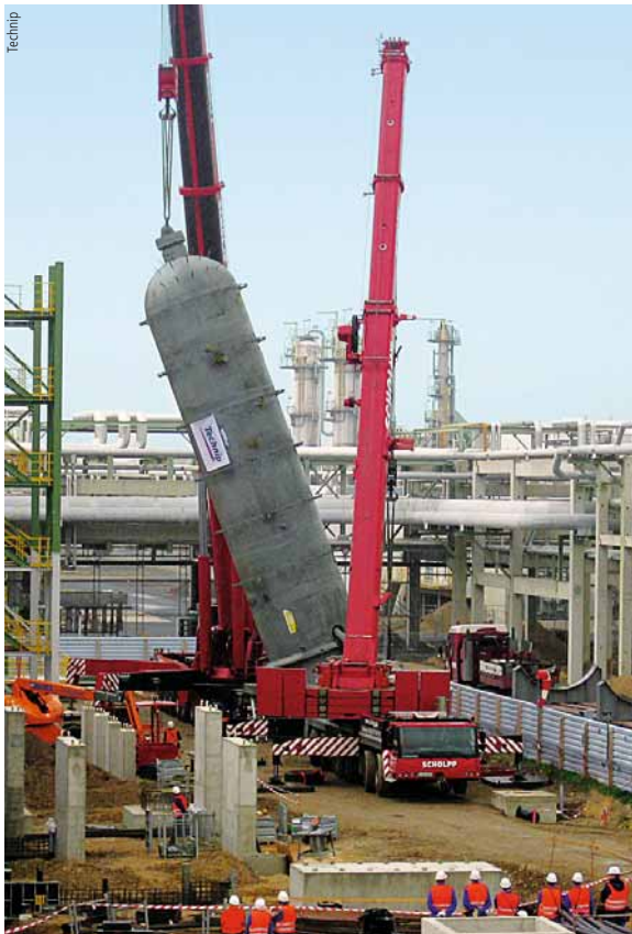
Der fast 20 Meter lange und 115 Tonnen schwere Reaktor reiste von Frankreich bis Leuna rund 5.000 Kilometer weit.
