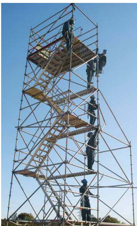
Sicheres Arbeiten auf Gerüsten hat bei BIS oberste Priorität. Dies belohnen die Kunden.
