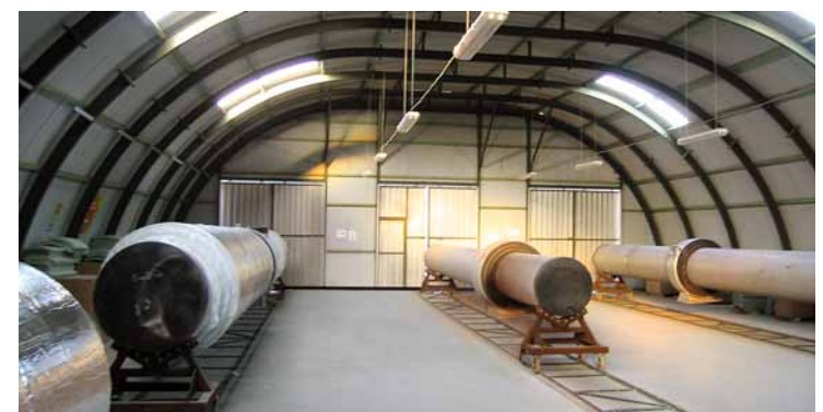
Fertigung und Isolierung der Rohrleitungen erfordern in Südfrankreich Schutz vor dem Mistral.
