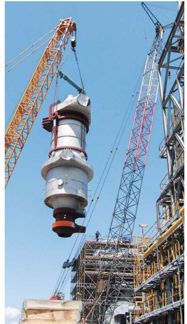
Der 330 Tonnen schwere Styrolreaktor machte im BASF-Werk in Antwerpen den Einsatz eines Spezialkrans erforderlich.
