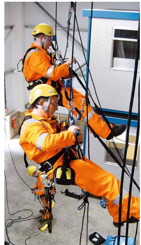
Seilunterstütztes Arbeiten wird in den Skills Centres der BIS Salamis intensiv trainiert.
