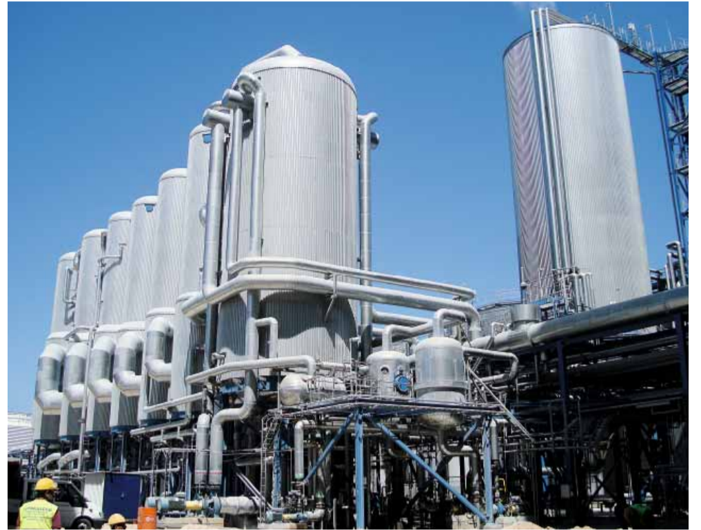
Das neue Verdampfungssystem wurde mit Steinwolle isoliert und mit Edelstahl verkleidet.
