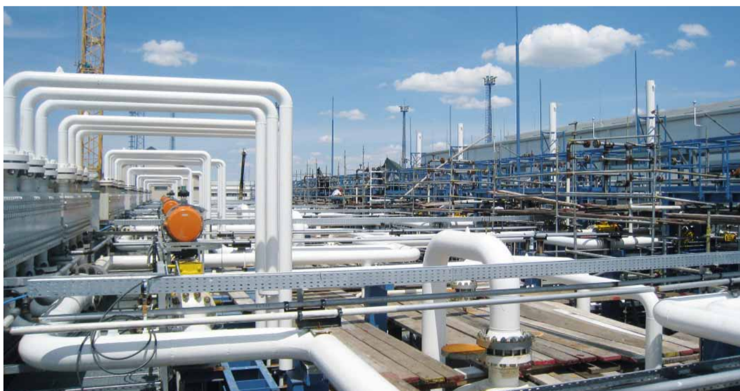
Ober- und unterirdische Hochdruckleitungen mit einem Gesamtvolumen von 260 Tonnen wurden für den Erdgasspeicher „Szőreg-1“ benötigt. Rund 60 Prozent der Vorfertigung erbrachte BIS Hungary in der Werkstatt in Tiszaújváros.
