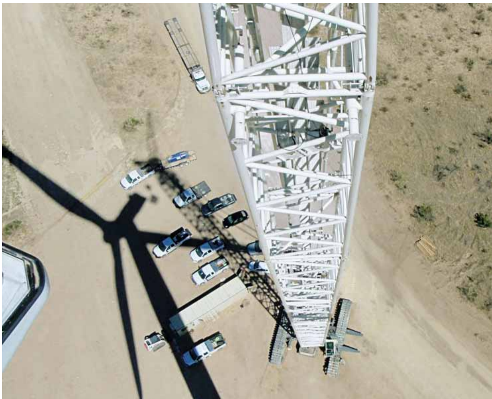
Einige Windanlagen haben eine Höhe von mehr als 90 Metern. Um das 20 Tonnen schwere Getriebe wechseln zu können, setzt BIS Salamis Inc. einen der weltweit größten mobilen Kräne ein.
