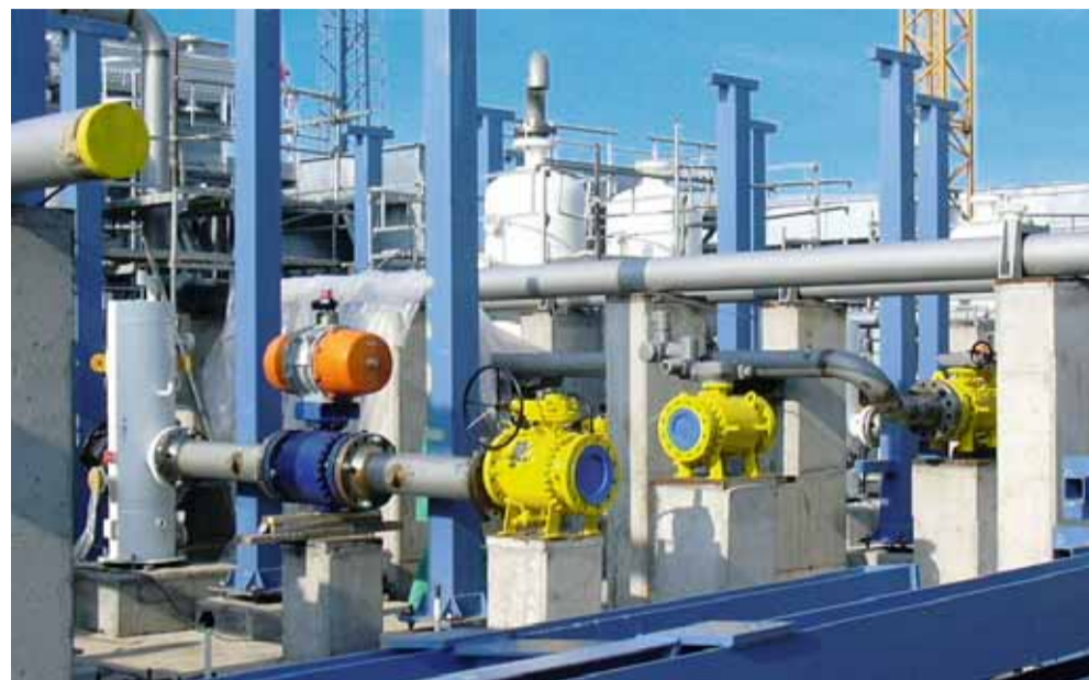
Auf extrem hohe Betriebsdrücke von 120 bis 160 bar sind die Rohrleitungen des neuen Gasspeichers ausgelegt. Entsprechend sorgfältig wurden die Schweißnähte geprüft.
