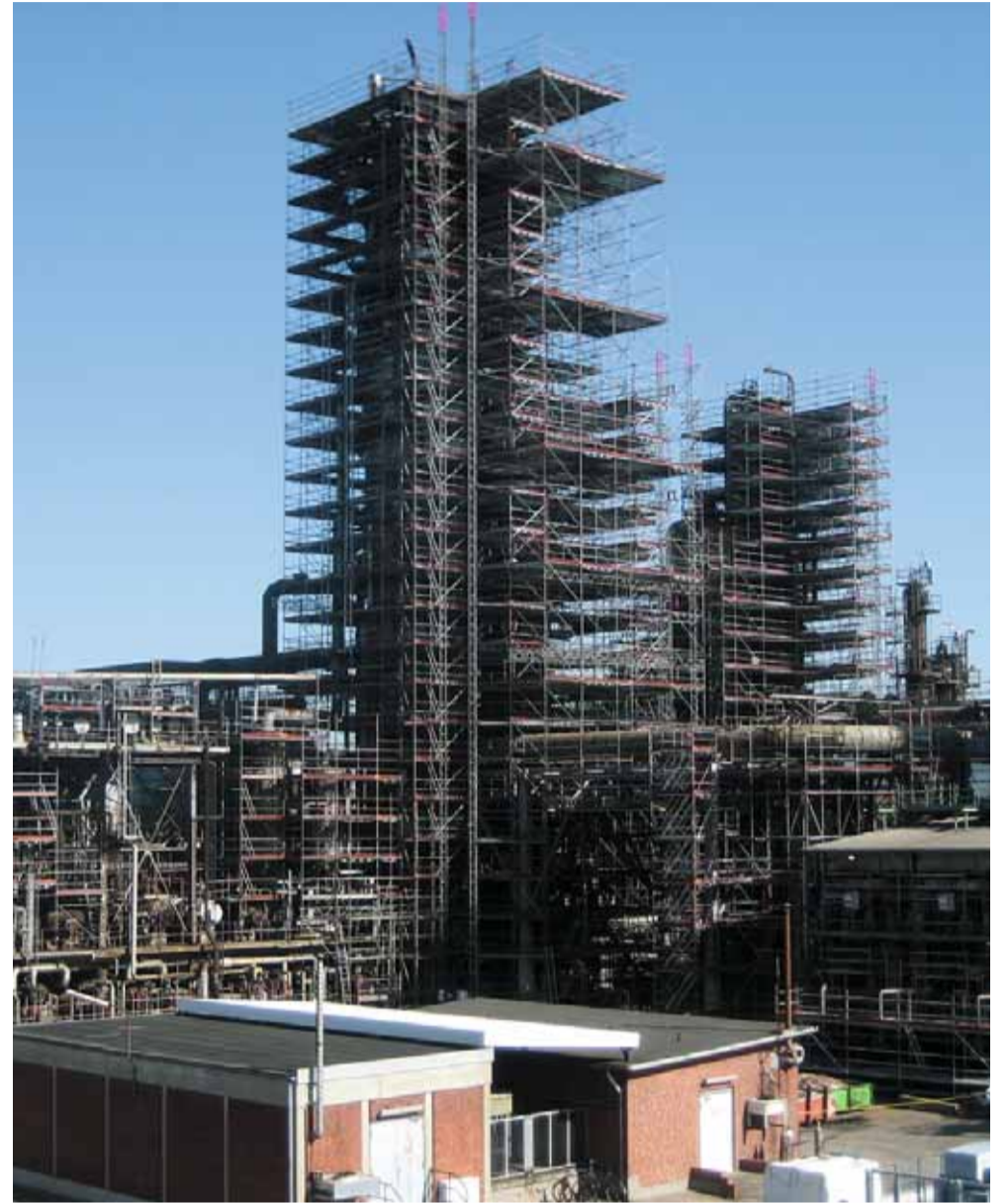
Beim zweiten Großstillstand im Nordbereich der Raffinerie mussten vier Kolonnen eingerüstet werden. Allein für eine Kolonne belief sich das Volumen der Gerüste auf 16.000 m³.
