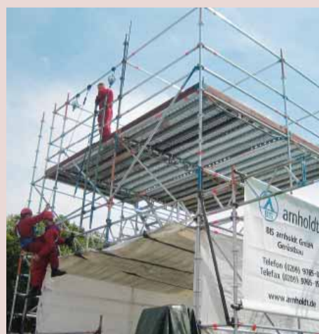
An einem Gerüst von BIS arnholdt demonstriert die Firma Evers die professionelle Höhenrettung.
