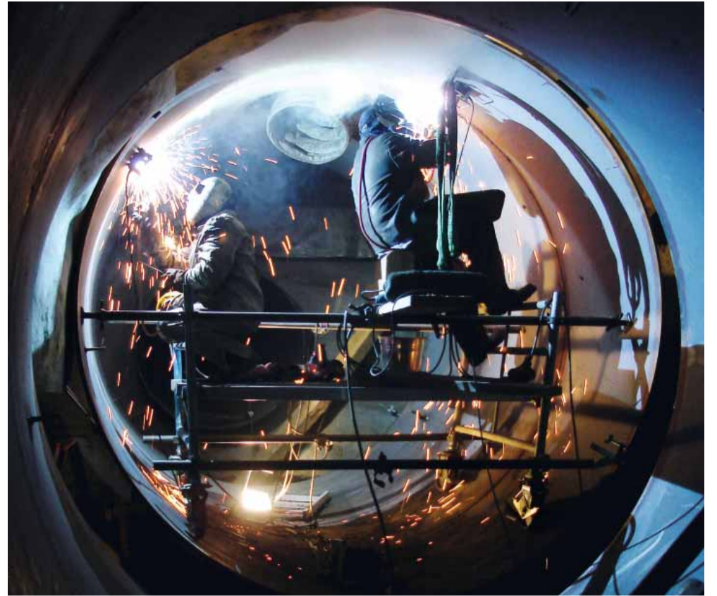
Der größere Durchmesser der neuen Rohrleitung ließ rechts und links neben dem Rohr wenig Platz zum Arbeiten. Daher mussten die Schweißarbeiten innen ausgeführt werden. Der Schweißrauch wurde durch Schläuche abgesaugt.
