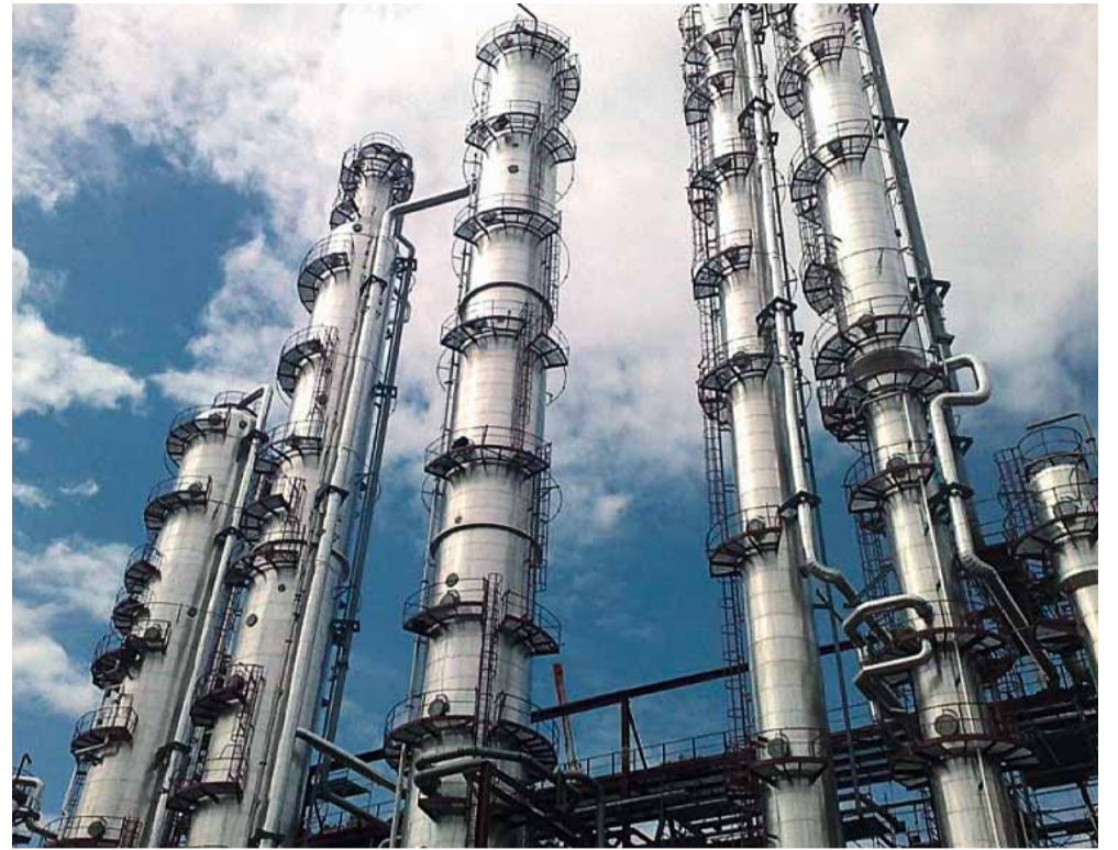
Für die Erweiterung der Butadienproduktion im Werk Kralupy wurden insgesamt 13 Kolonnen aufgestellt.
